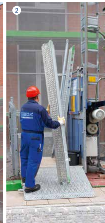
2 Платформа и рампа предназначены для тяжелых грузов.
