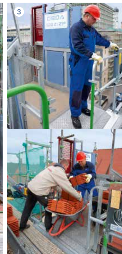
3 Безопасный уровень устанавливается в местах погрузки и разгрузки в качестве защиты от падения
